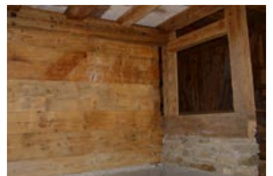
Eine traditionelle Fleckenwand, die bei der Sanierung mit konisch gesägtem Altholz teils neu bestückt wurde; teils wurden die Balken aufgesägt und partiell ersetzt.
