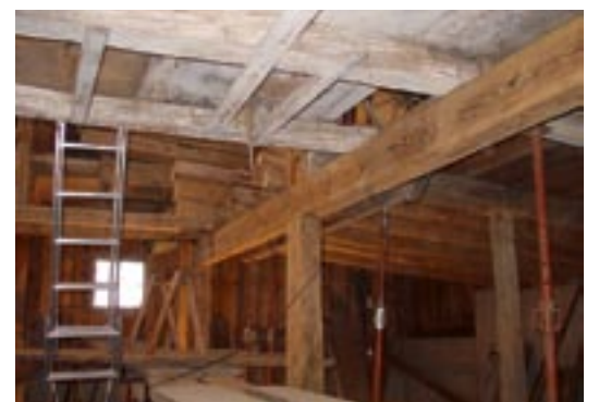
Vorher: Die notdürftig stabilisierte, schwache Deckenkonstruktion vor der Sanierung.
