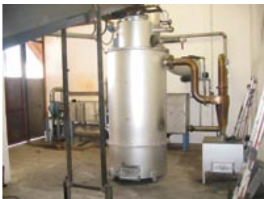
Die selbst konstruierte Holzgasanlage von Josef Behr. Hier wird das zu Hackschnitzel verarbeitete Abfallholz vergast und ein Blockheizkraftwerk zur Strom- und Wärmeerzeugung betrieben.
