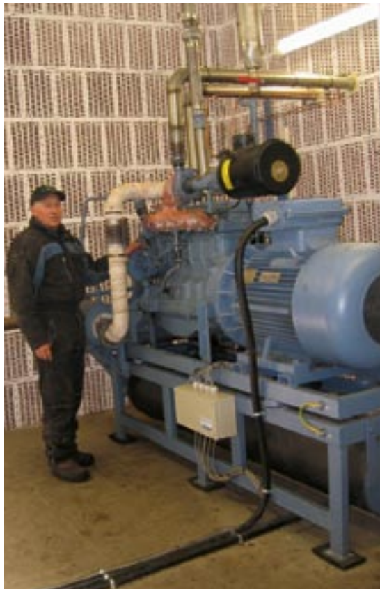
Josef Behr am Motor seiner Holzgasanlage, dem Blockheizkraftwerk, das pro Stunde 75 Kilowatt Strom und 130 Kilowatt Wärme bei niederem Abgaswert erzeugt.
