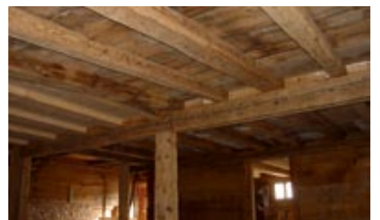
Nachher: Die Balkenlage der neuen Decke wurde mit 300 Jahre altem Altholz neu errichtet und hält jetzt Ausstellungsgerät und Besuchergruppen stand.
