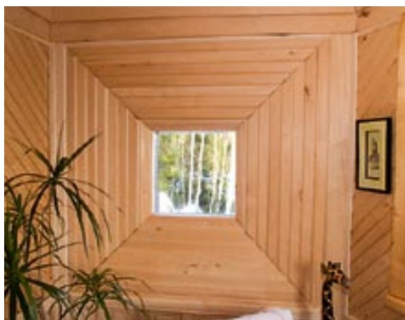
Eine optische Täuschung aus Leisten: Es scheint, als sei das Fenster am Ende eines Tunnels. Die Mauer ist eben.
