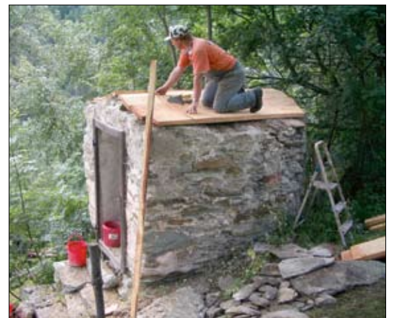
Jens Cavigelli montiert die erste Schicht des Dachwiederaufbaus aus Birnenholzbrettern.
