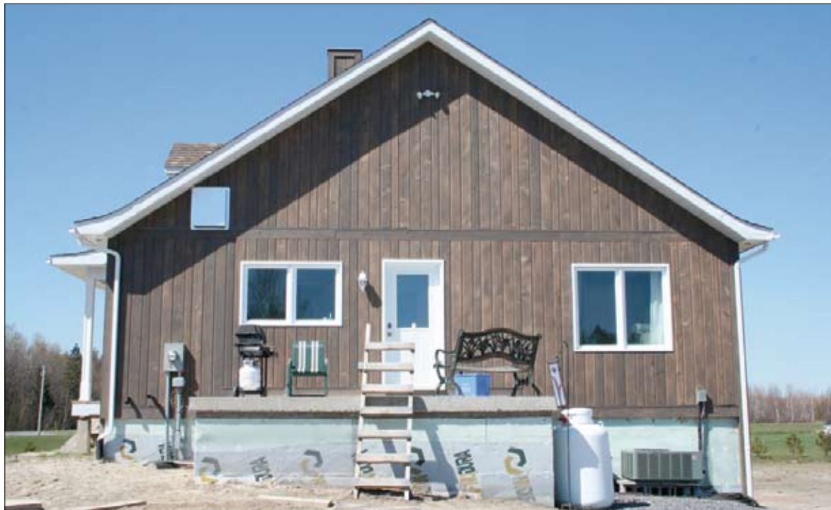
Die Weymouthskiefer-Schalung wurde mit dem Vierseitenhobel PH260 gefertigt.
