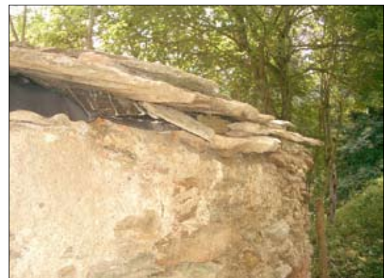
Die alten Dachsteine wurden mit Mörtel fixiert und verbergen die durch eine Teichfolie vor Feuchtigkeit geschützte Birnenholzdecke.
