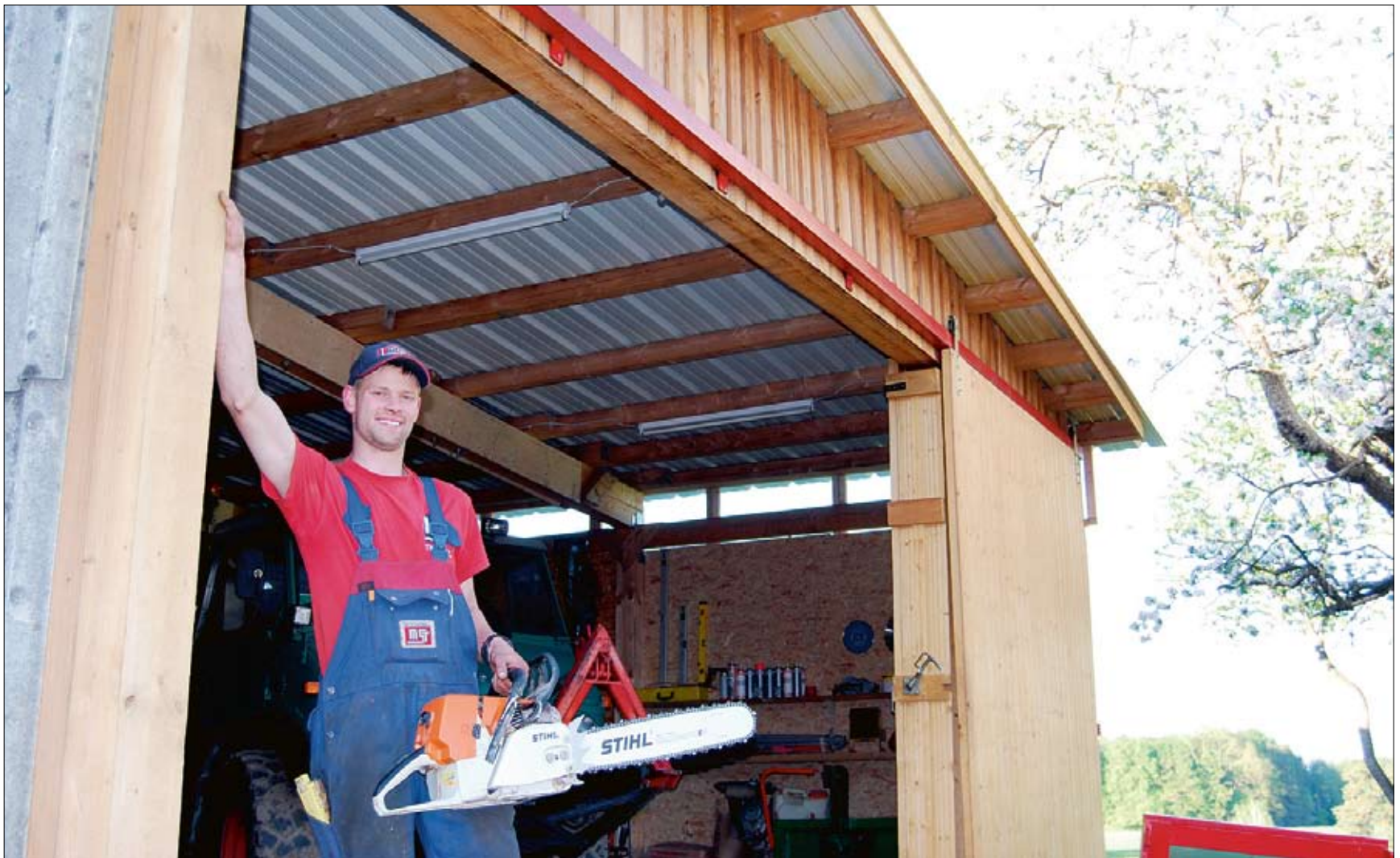
Mit der M7 und Holz aus dem eigenen Wald hat Michael Hartinger sich kostengünstig seinen Maschinenschuppen gebaut.
