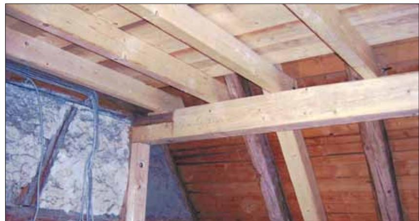
*Genau nach Plan des Architekten und den Berechnungen des Statikers wurden Deckenbalken verlegt, marode Pfetten und Sparren ausgetauscht, das Kehlgebälke gelegt, und die Firstpfette aufgedoppelt.*
