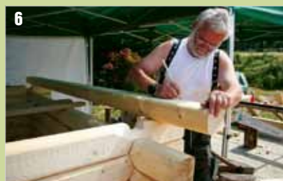
6 Erich Pohl beim Anreißen einer Verkämmung.
