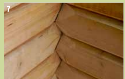
7 So wurde Lage für Lage ausgearbeitet.
