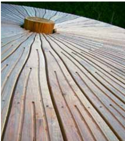
Die ergonomisch geformte Balkonfläche mit sternförmiger Wasserablaufrinne gleicht einem Kunstwerk.
