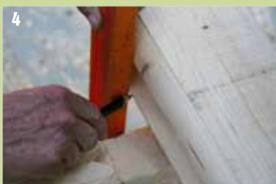
4 Das erste Holz der Querwand wird angerissen.
