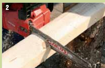
2 Die ersten Schnitte für die Verkämmung.
