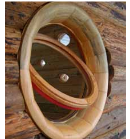
Dieses runde Astloch-Fenster ist keine Standardlösung, sondern es steckt viel ausgefeilte Technik in der Holzrundung, ebenso im individuell angefertigtem Scharnier.
