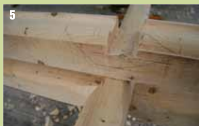
5 Halb ausgearbeitete Verkämmung.
