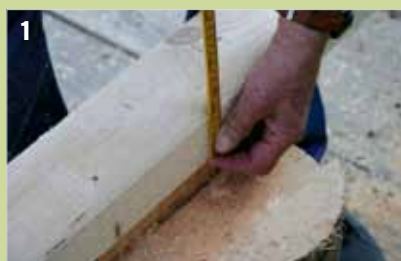
1 Erster Schritt: Das Anreißen der untersten Fußschwelle.
