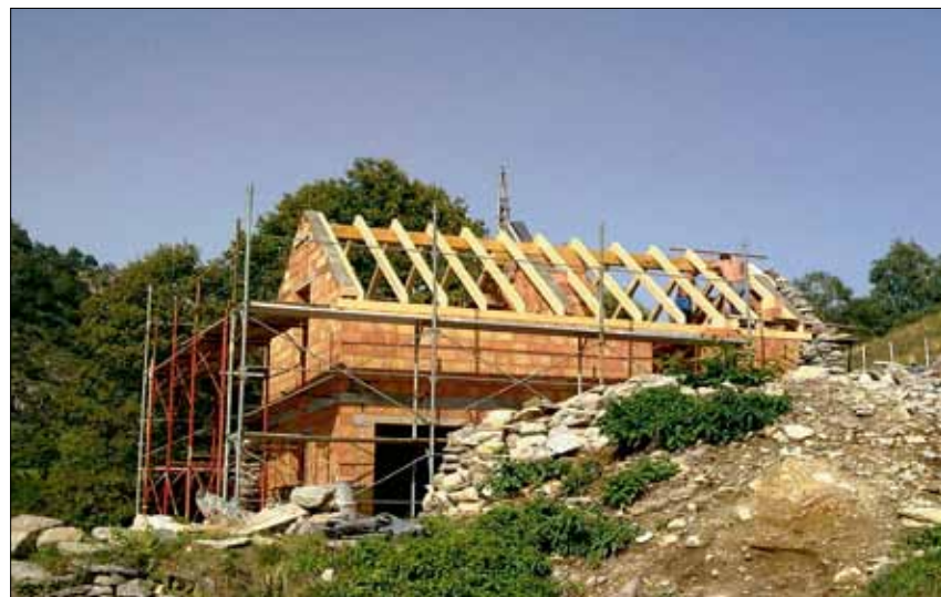
Das neue Rustico im Rohbau mit Firstbalken aus Kastanie.
