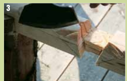
3 Hier wird der Schalm mit dem Beil behauen.
