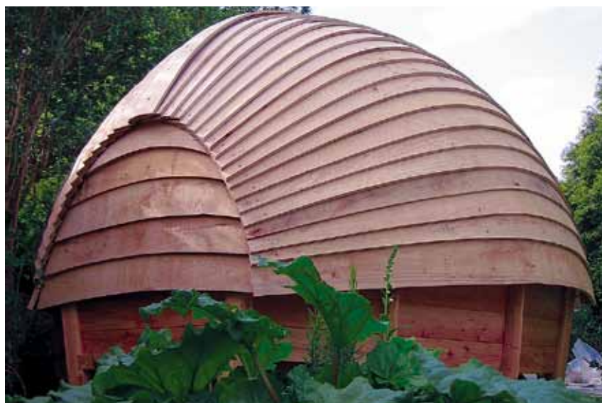
Die Technik für das gebogene Dach stammt aus dem Holzbootbau.
