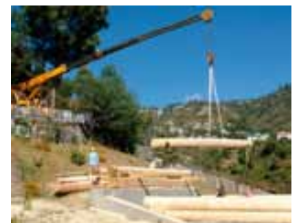
• Die erste Holzlage wurde mit dem LMPPro besäumt und auf das Fundament aufgesetzt.
