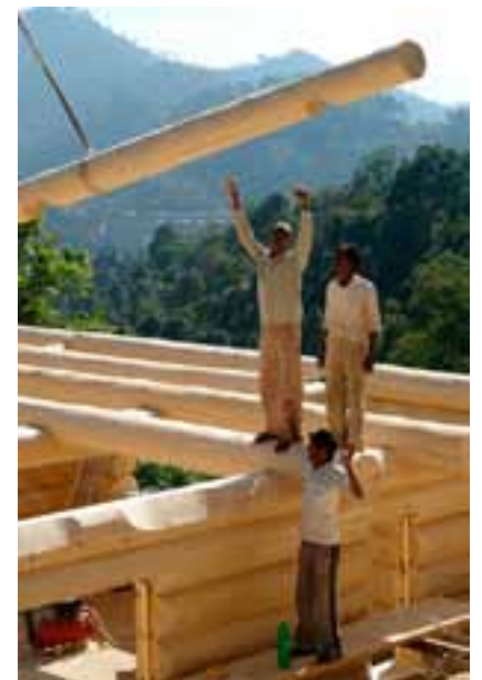
• Die Balkenlage für die Deckenkonstruktion wird angebracht.
