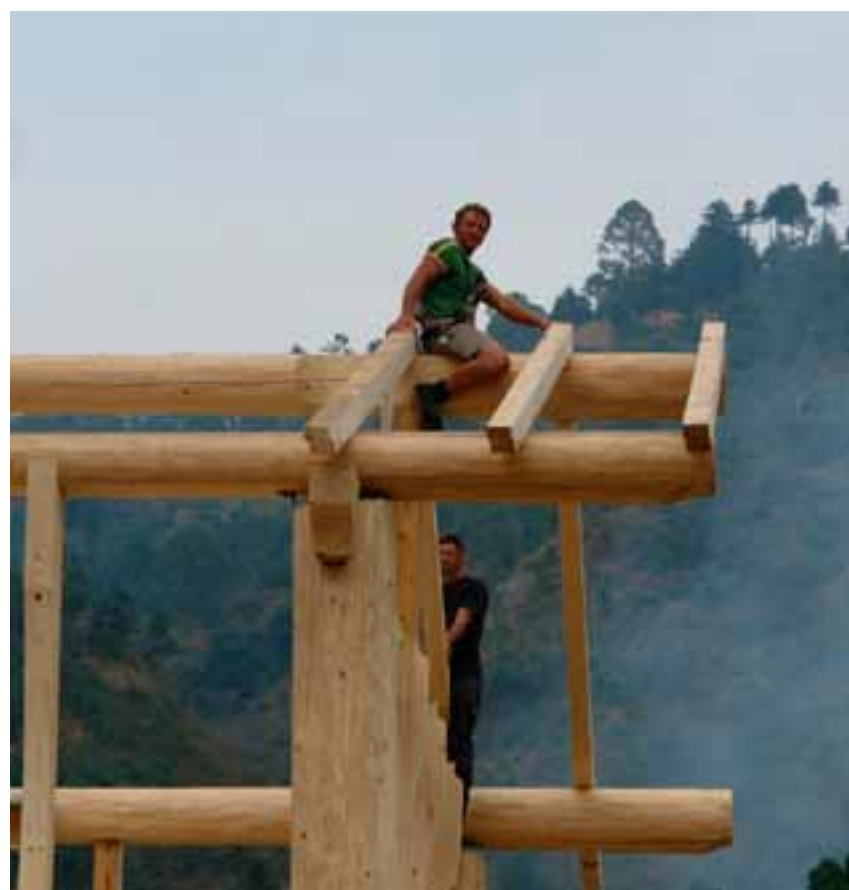
• Das Dach wird aufgerichtet.
