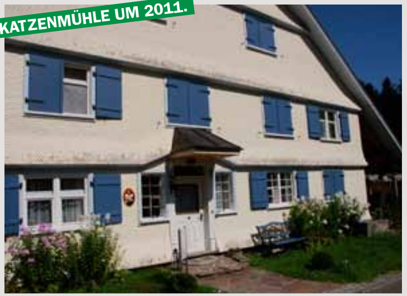
• Auf der Ostseite zeigt die Mühle ihr schönstes Gesicht. Auch die Schindeln hat Michael Bufler komplett erneuern müssen.
