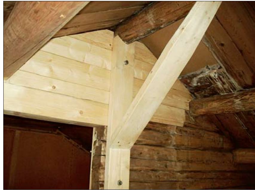
Teile der maroden Innenwände mussten ersetzt werden. Das Holz dafür hat Sepp Zabernig maßgenau mit seinem Logosol-Sägewerk M5 in Ruhpolding geschnitten.
