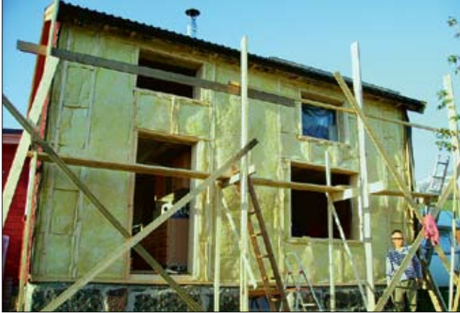
Renovierung in Schritten: Die Hauswand wurde komplett neu aufgebaut, isoliert, verschalt und mit landestypischen Vestland-Röd, einer kupferpigmenthaltigen Ölfarbe, gestrichen.
