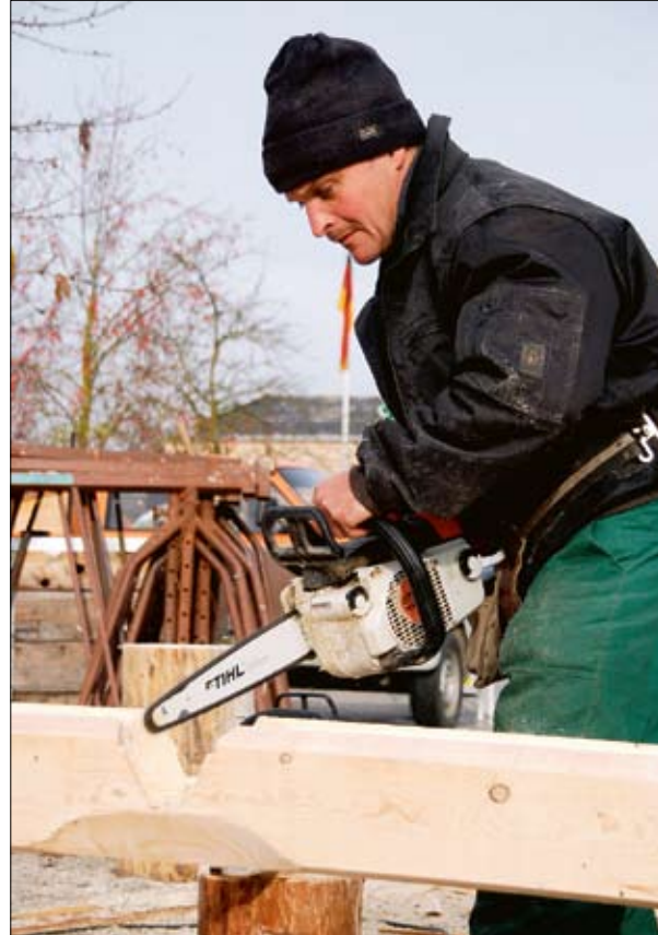
Mit Hilfe der Motorsäge mit Carving-Ausrüstung wird die Sattelkerbe ausgearbeitet.
