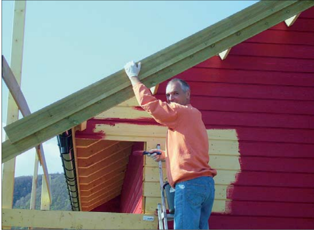
Renovierung in Schritten: Die Hauswand wurde komplett neu aufgebaut, isoliert, verschalt und mit landestypischen Vestland-Röd, einer kupferpigmenthaltigen Ölfarbe, gestrichen.
