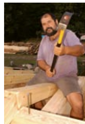
Der letzte Nagel im Firstbalken: Der Rohbau der ersten Hütte für das Luzica-Camp ist bereits abgeschlossen, im nächsten Jahr soll eine weitere Hütte dazukommen.
